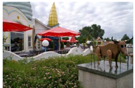
Die Raststätte Illertal Ost
